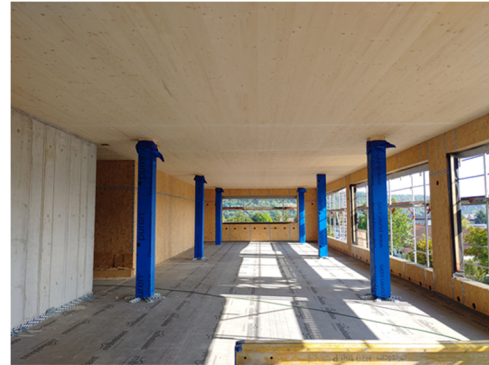
Abb. 33: Ansicht punktgestützte Flachdecke (Rohbau)
