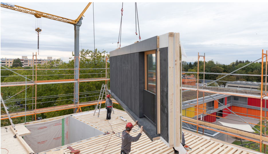
Abb. 18: Außenwand mit fertiger Fassade und Bauteilstoß
