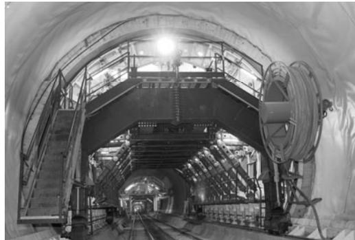
*Bild 0.22: Variable Tunnel Schalung*
